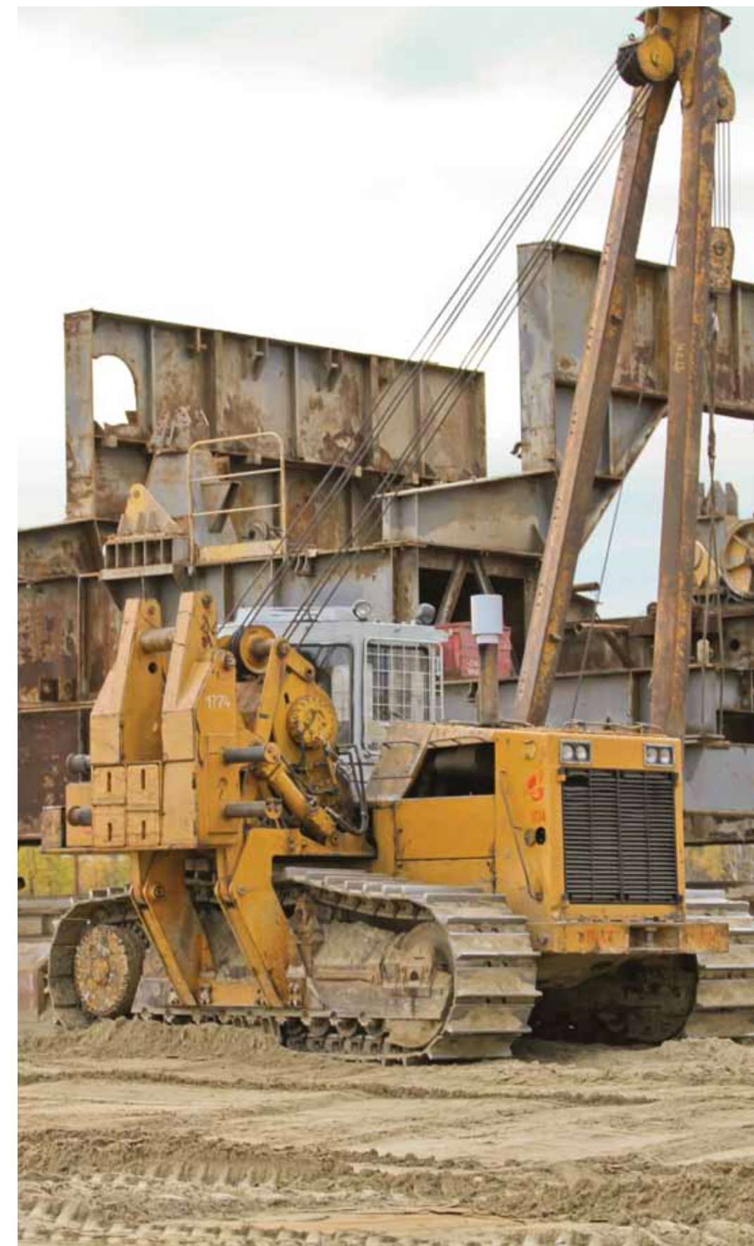
▲ На снимке: ЧЕТРА ТГ-503К ведет монтаж буровой вышки
