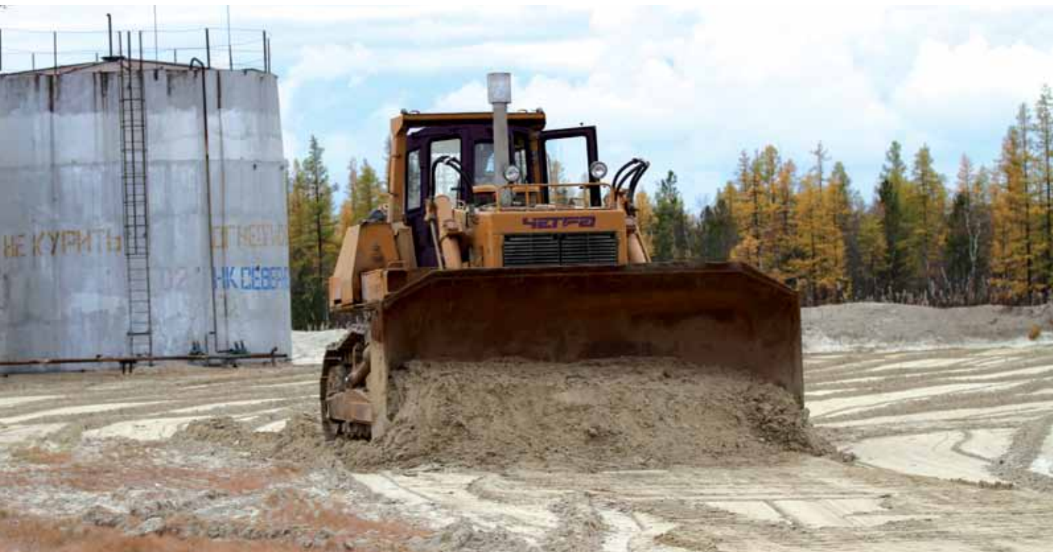
▲ На снимке: ЧЕТРА Т35 осуществляет планировку площадки бурового куста
